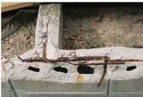
腐食して内部で体積膨張していた横筋がブロックを破壊し、地震で倒壊した事例
