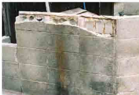
腐食して内部で体積膨張していた横筋がブロックを破壊し、地震で倒壊した事例
